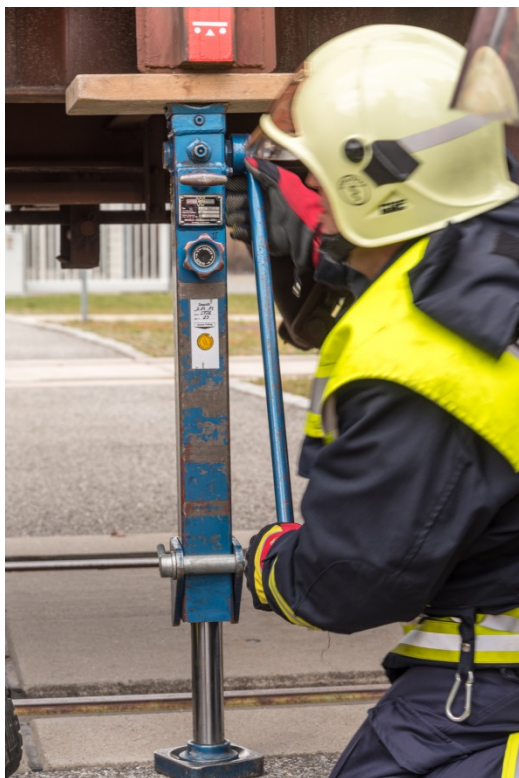
Abbildung 44: Anheben mittels Büffelheber
