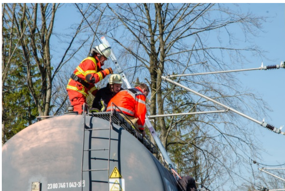
Abbildung 59: Absturzgefahr besteht in den Dachbereichen von Eisenbahnfahrzeugen
