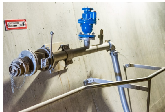
Abbildung 49: Schlauchanschlusseinrichtung
