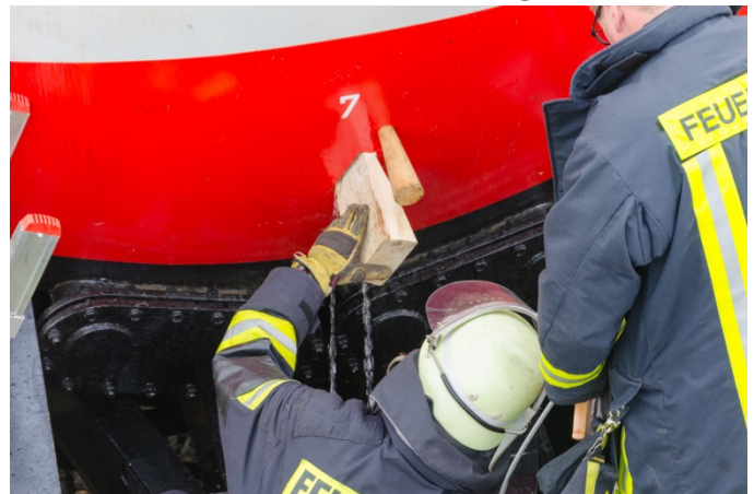
Abbildung 19: Abdichten eines Risses im Kessel
