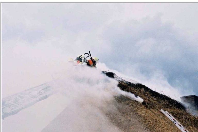
Abbildung 9 - Abdecken/Öffnen des Firstes mittels Drehleiter
