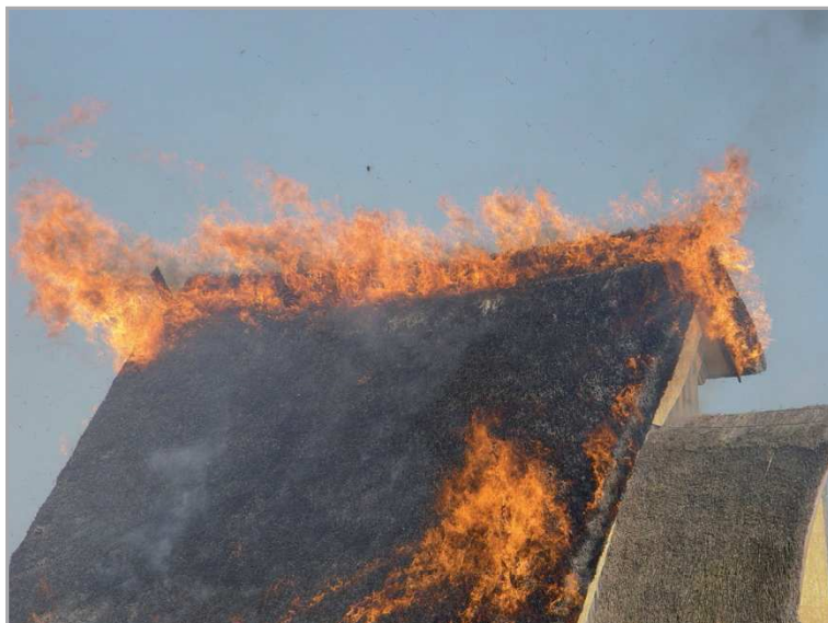
Abbildung 14 - Glimmbrandphase mit Flammeneerscheinungen vorwiegend an den Rändern/First
