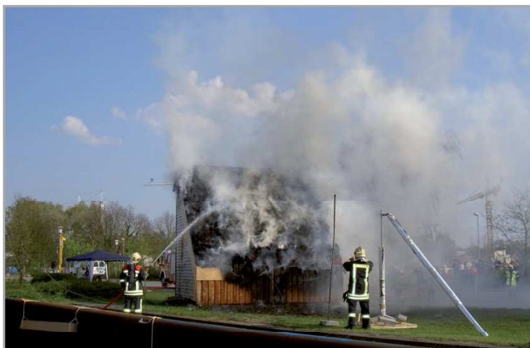
Abbildung 17 - Einsetzen der Löschrmaßnahmen
