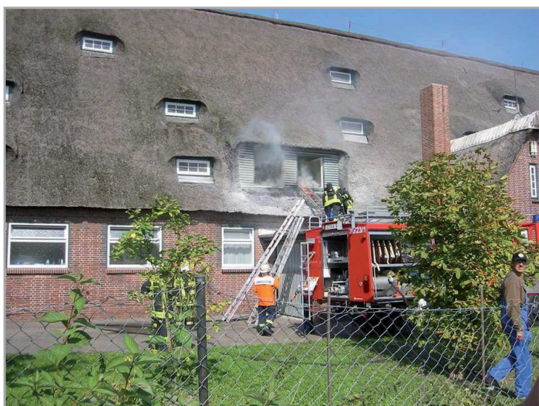
Abbildung 19 - Brandherd unterhalb einer Gaube in der Hinterlüftungsebene
