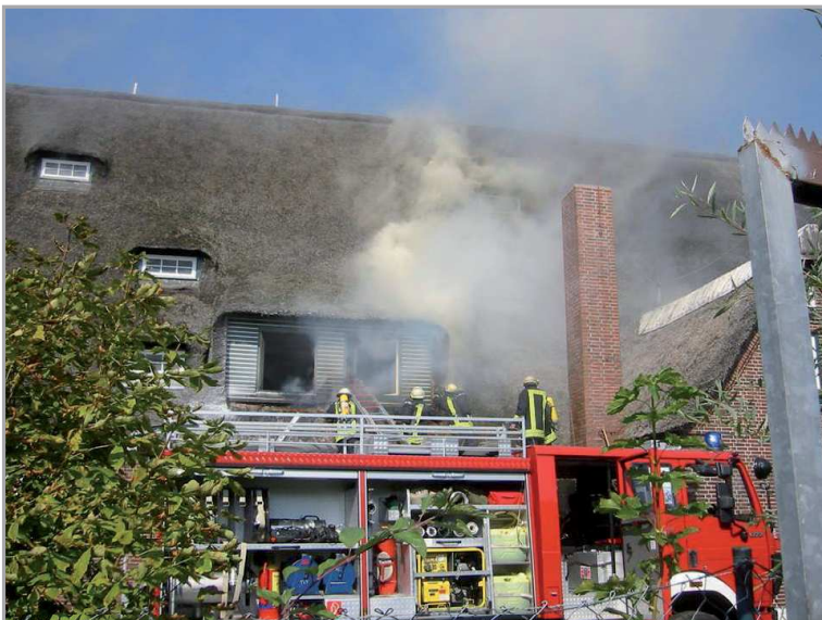
Abbildung 21 - Rauch entweicht aufgrund weiterer Ausbreitung bereits im Firstbereich
