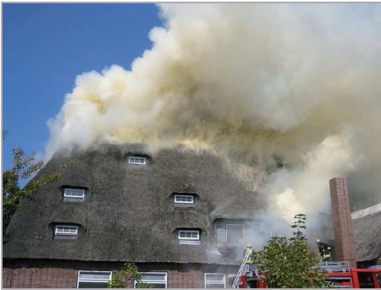
Abbildung 22 - Aufgrund thermischer Aufbereitung entweichen große Mengen Rauch. HINWEIS: Sofortige weiträumige Evakuierung aller Personen um das Brandobjekt veranlassen!
