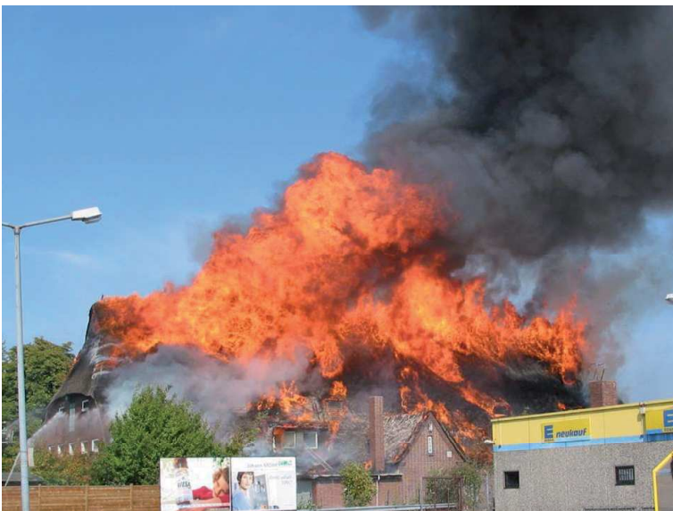
Abbildung 23 - Schnelle und großflächige Durchzündung des Daches
