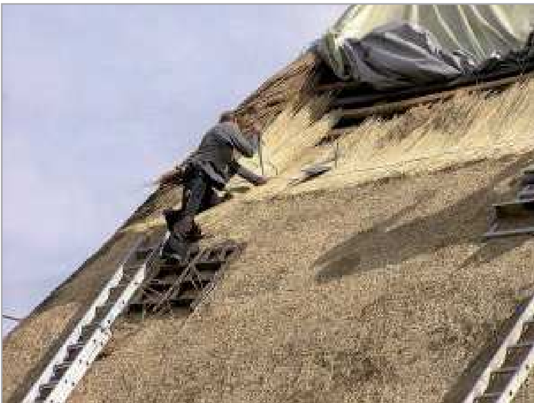
Abbildung 3: Verwendung eines Dachdeckerstuhls bei Arbeiten auf dem Reetdach
