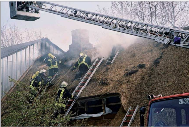
Abbildung 10 - Entfernen des Reet rundum den Brandherd mit Leitern und Deckstühlen
