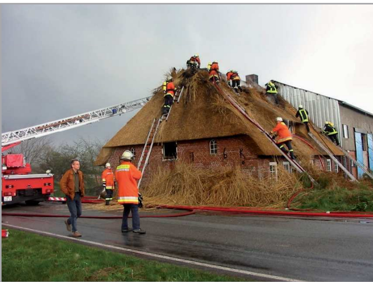
Abbildung 11 - Entfernen des Reet im betroffenen Firstbereich
